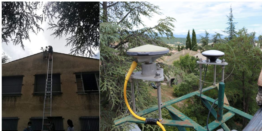
FIGURE 3 – Photographie lors de l'installation de l'antenne sur le toit du centre IGN à Forcalquier
